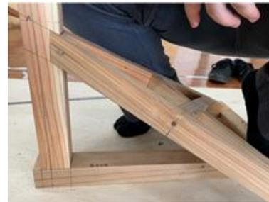
図 14 屋根筋かいと振たる木の組立て
